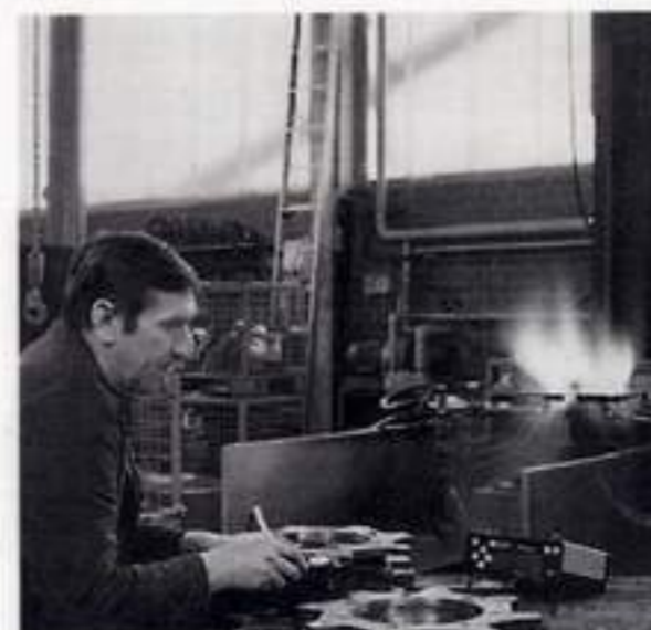
5: Härteprüfung an einer Ritzelwelle
